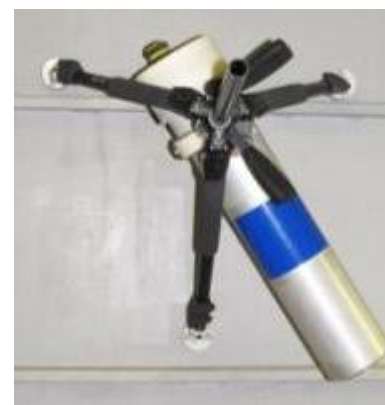
Рис. 3. Пример крепления моноблока аппарата семейства 0,3 СБК на металлической переборке.
